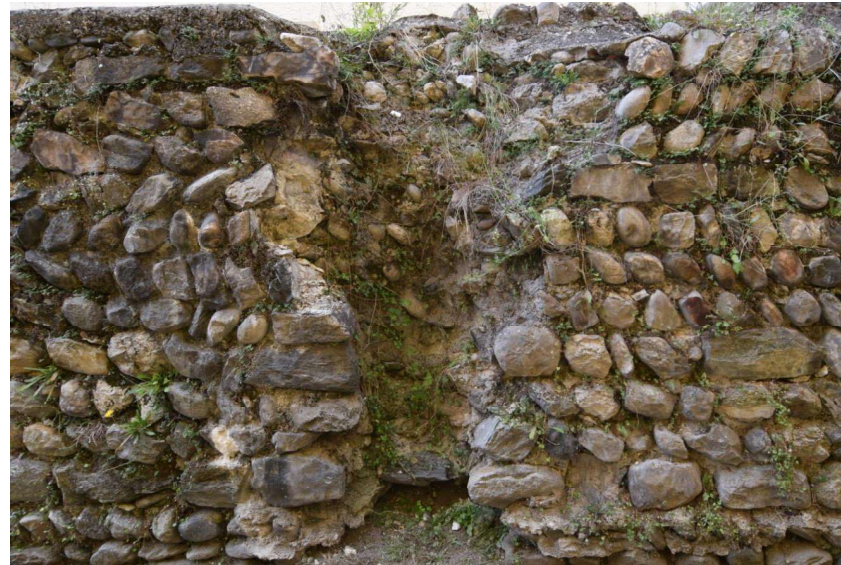
Abgetragenes Mauerwerk
