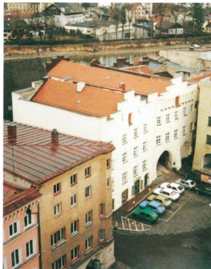
Während der Sanierung 1987
