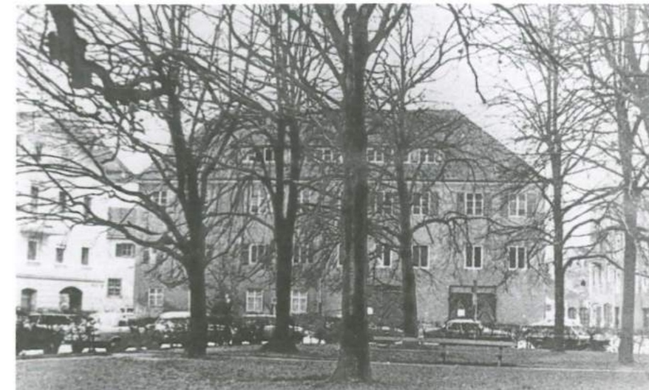
Blick vom Heisererplatz auf die westliche Platzwandbegrenzung. Das frühere Gebäude der alten Realschule
