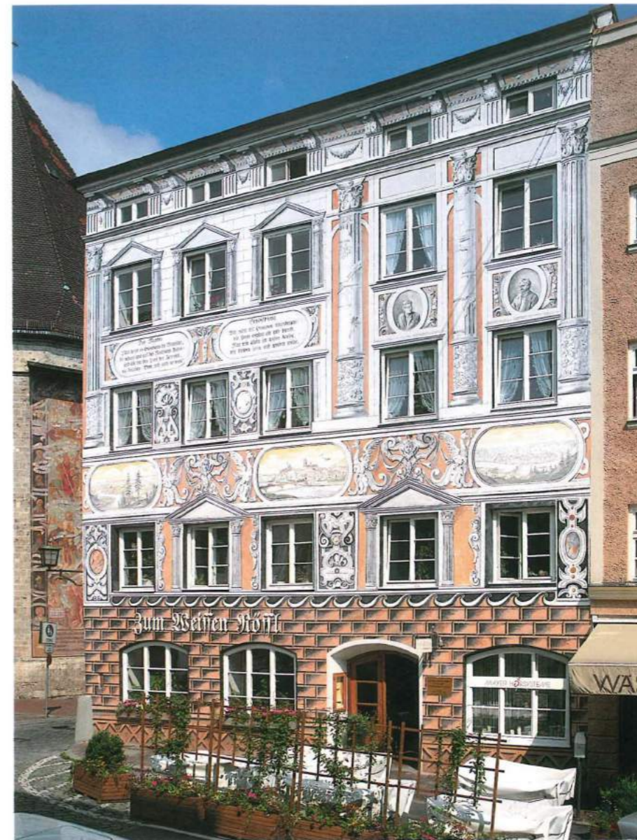
Fassade nach der Renovierung
