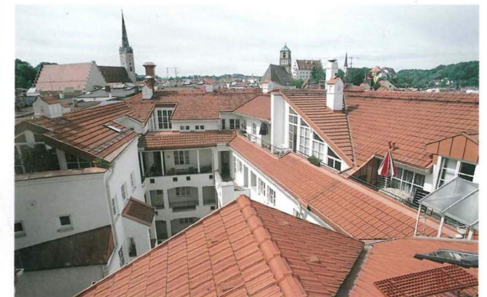
Innenhof und Dachlandschaft
