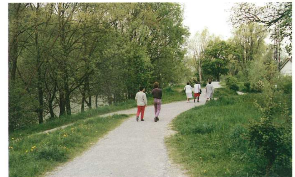
Hochwasserschutz und Uferpromenade
