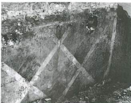
Befundstelle über ca. 4 m 2 erhaltener Fassung aus dem 15. Jahrhundert
