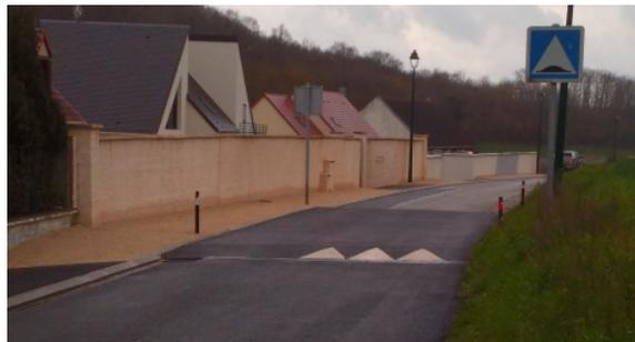
Weitere gestalterische Elemente in Form von Einbauten in der Fahrbahn wie z. B. in Raubling-Nicklheim (Foto mitte, sanfte Schwelle) sind bereits grenzwertig, da sie in Deutschland prinzipiell nicht erlaubt sind. Die z. B. in Frankreich üblichen abrupten Schwellen (Foto unten) sind zwar sehr wirkungsvoll, hier jedoch grundsätzlich verboten. Rettungsdienste wie auch Fahrradverbände stehen diesen Elementen überwiegend kritisch gegenüber.
