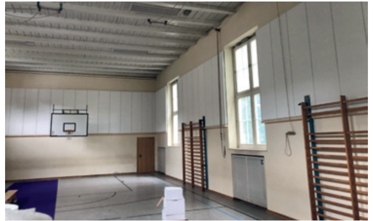
Die weißen Platten an den Wänden schlucken Schall und haben sich bereits in der Praxis sehr bewährt
